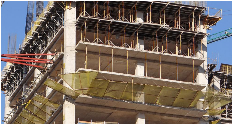
รูปที่ 1.10 แสดงลักษณะการป้องกันลูกไฟกระเด็นจากด้านบน
